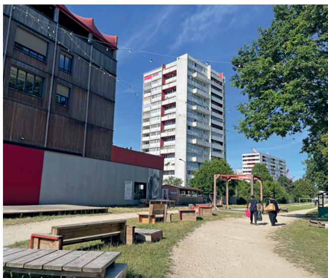
Mobiliers installés sur la Promenade de la Dhuys
