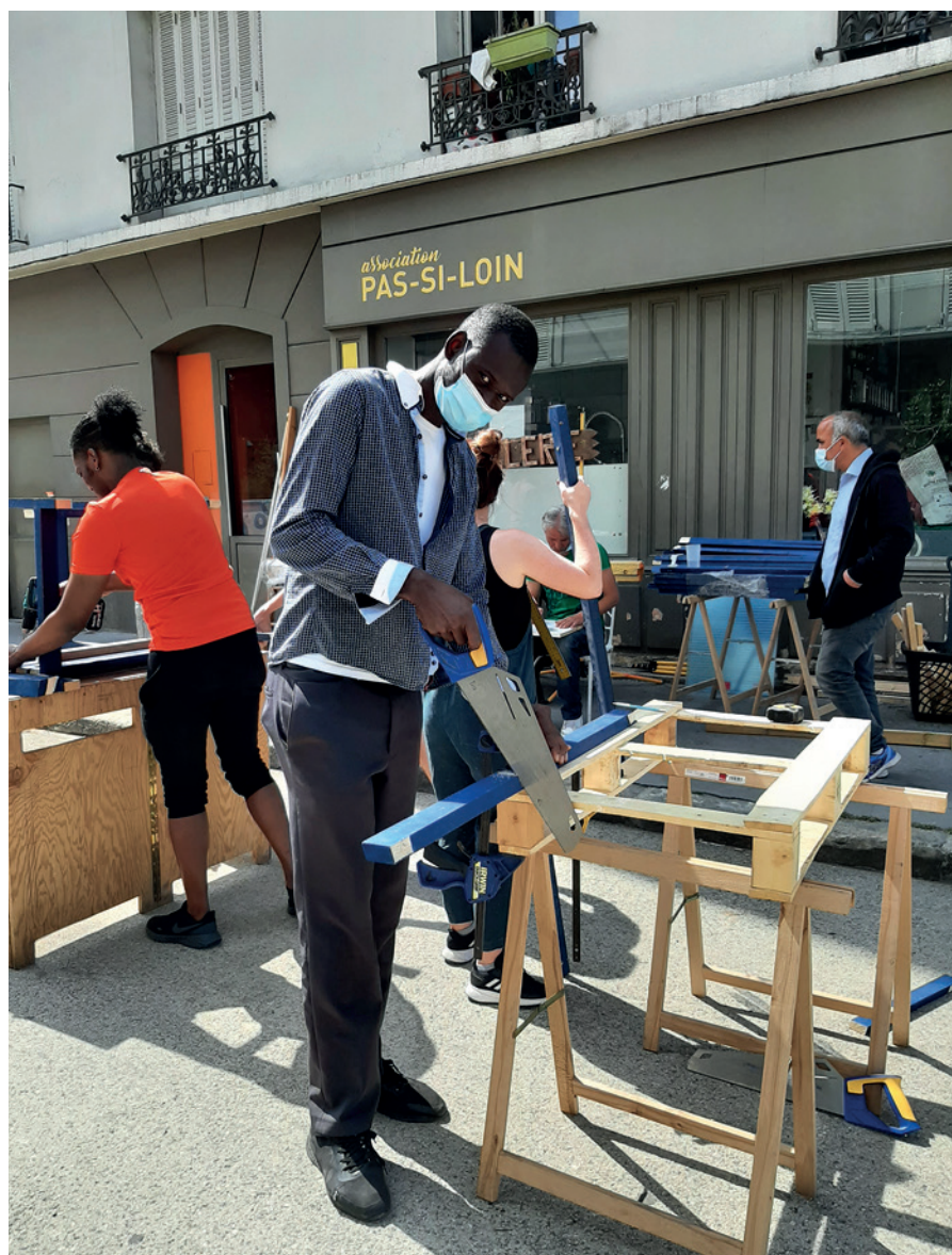
Des bénévoles sur le chantier participatif de l'aménagement intérieur du Pas-Si-Loin
