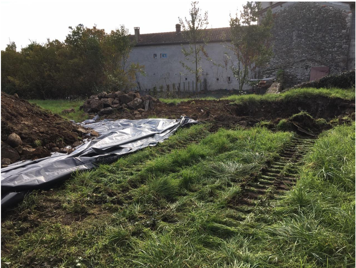
Aménagement en cours, Nouvelle-Aquitaine
